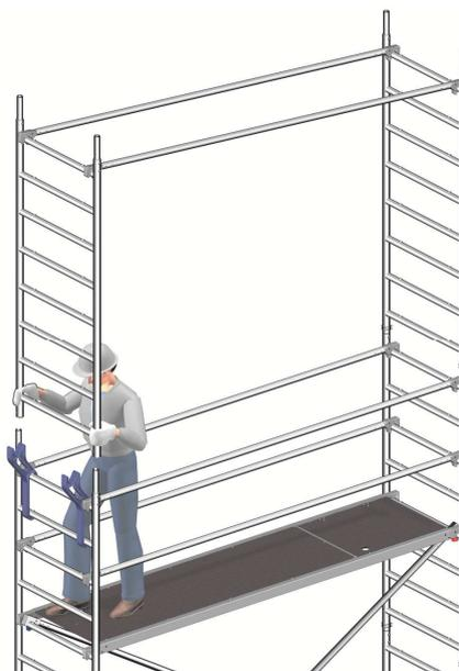
2. Sollevare il telaio, con i correnti ad esso collegati, e assemblarlo al telaio sottostante
